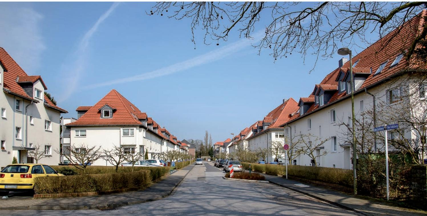
Die Häuser Am Goldberg im neuen Gewand nach umfassenden Modernisierungen: gedämmte Fassaden, neu gedeckte Dächer und angefügte Balkone
