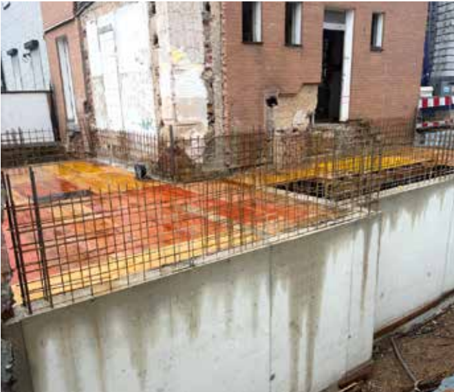
aktueller Bautenstand: die Bodenplatte ist gegossen, Kellerwände sind betoniert, Kellerdecke ist vorbereitet
