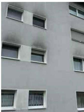
Sichtbare Folgen der Kipp-Lüftung sind Verunreinigungen der Fassade.
