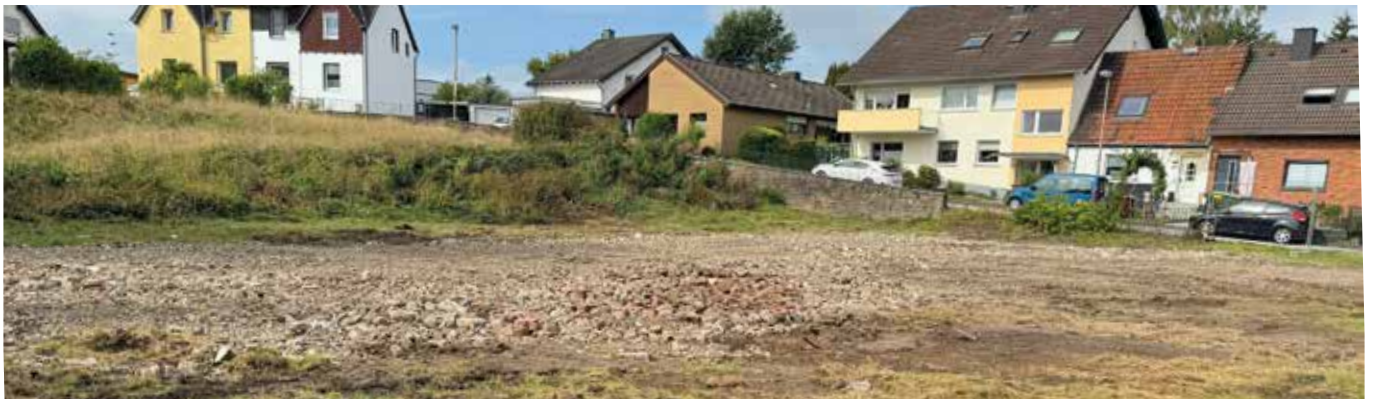
Am Stoß 14-16: Der Abbruch ist erfolgt, die Grube ist verfüllt
