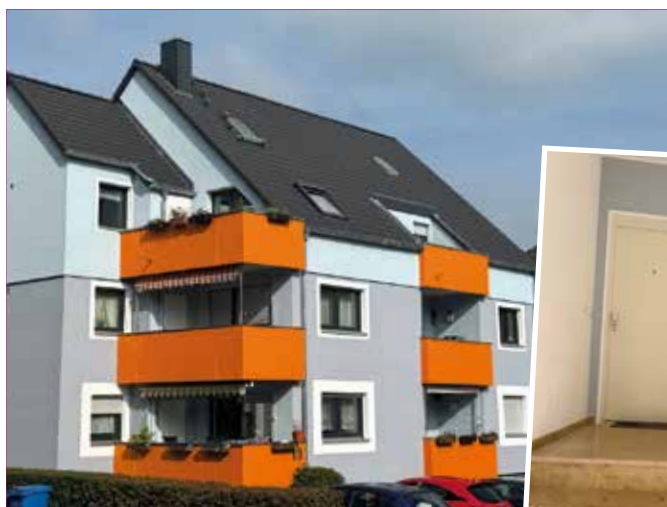
Peter-Bremer-Str. 19 nach der Maßnahme
