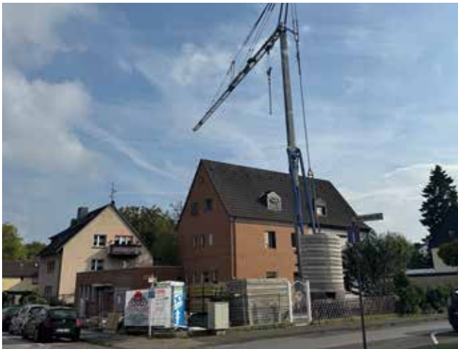
Baustelle Am Schraffenberg 21: Der Kran steht, die Entkernung läuft
